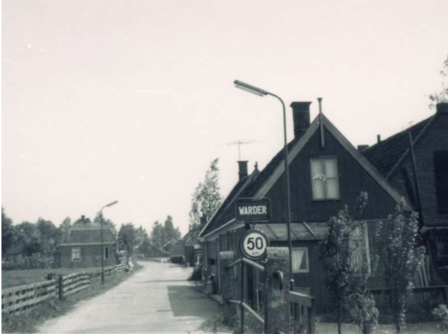
Westeinde Warder met op de voorgrond de brug over de Wijzend
