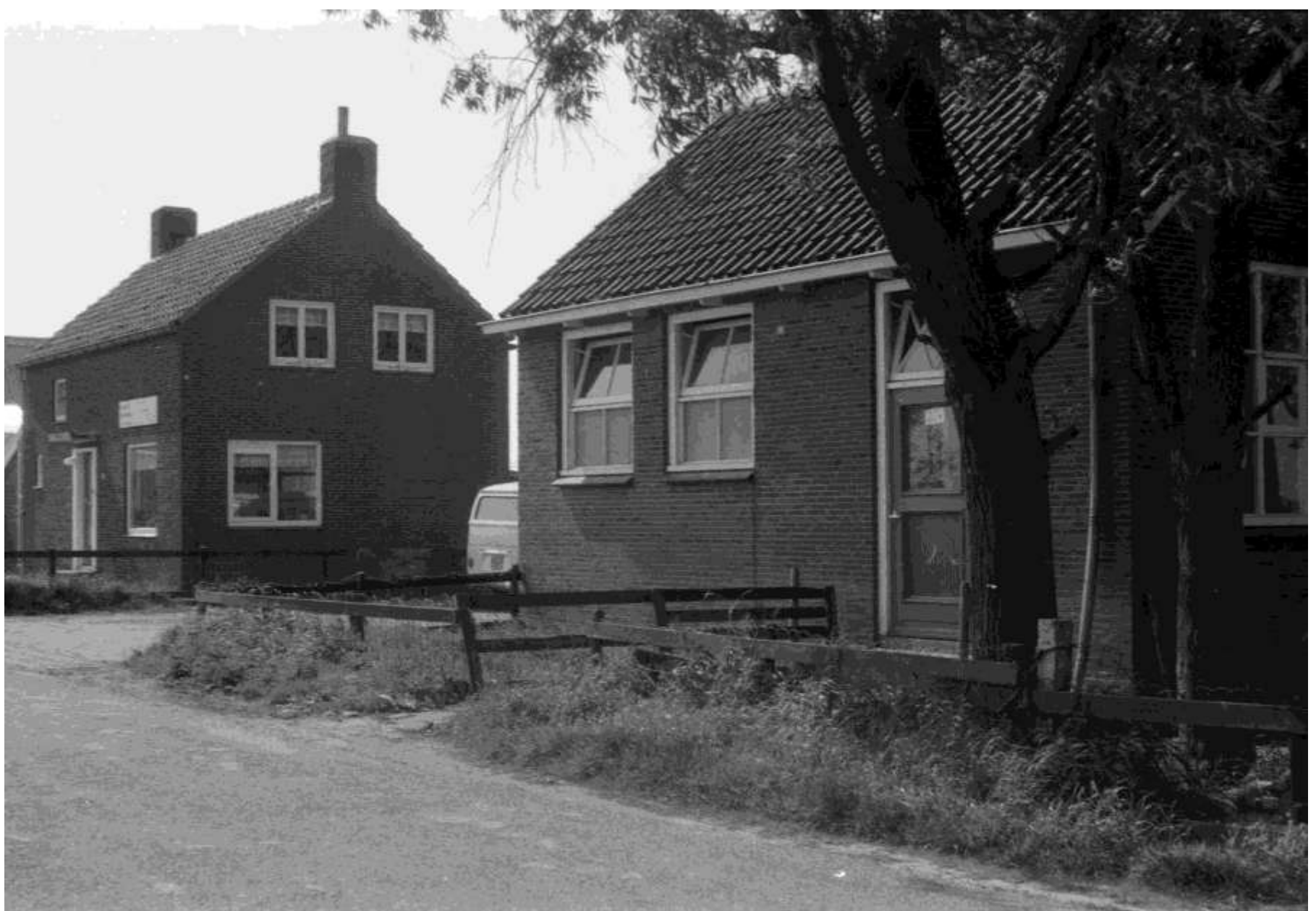
De nieuwe woning en noodslachtplaats
