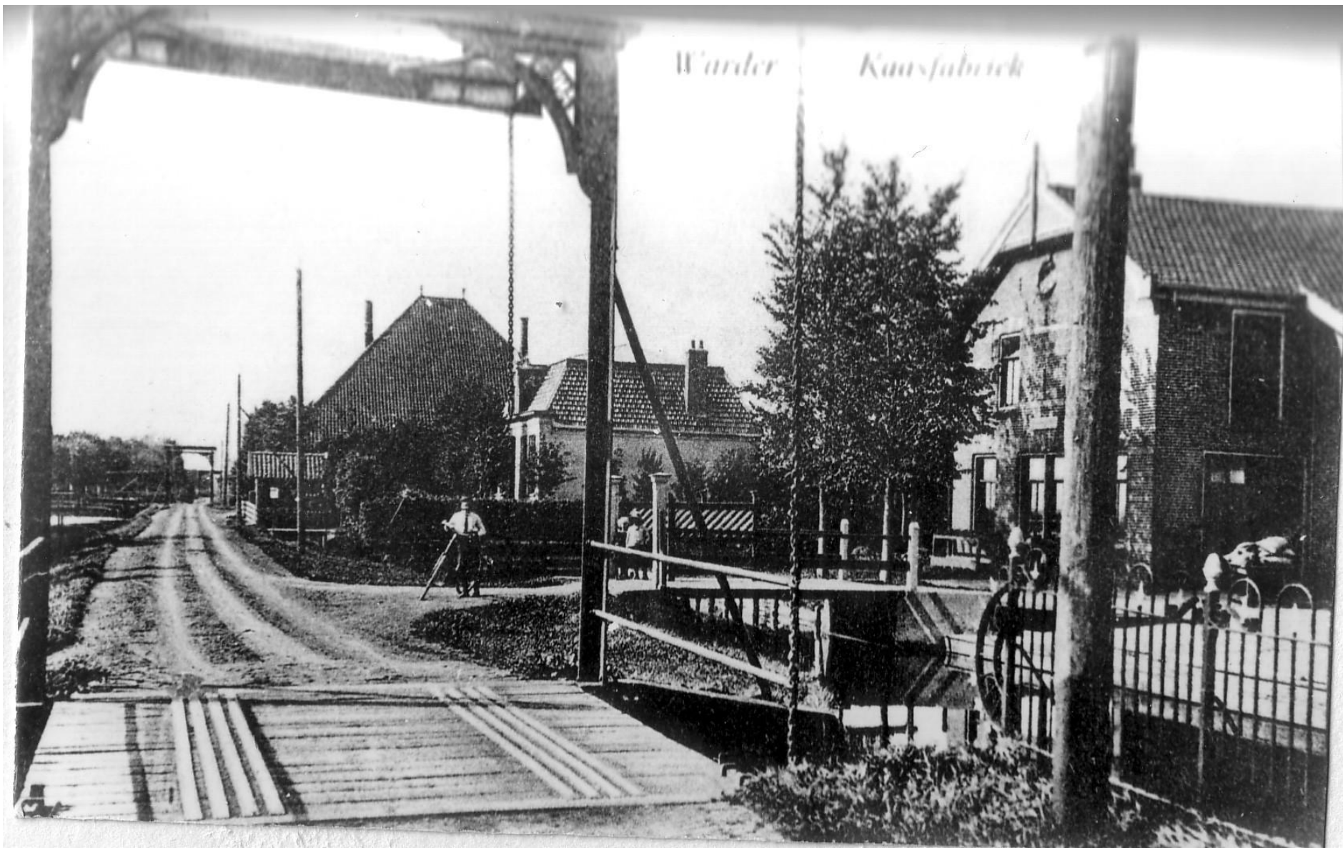
De palen zijn hier pas geplaatst
