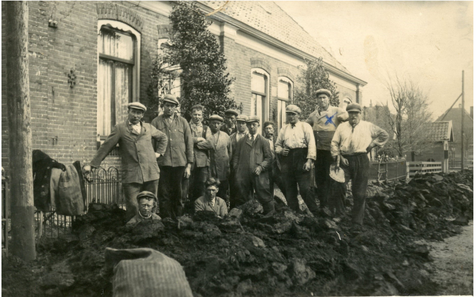
Aanleg van de waterleiding bij de boerderij van Dirk Dzn. Haan, een van de tegenstanders.
